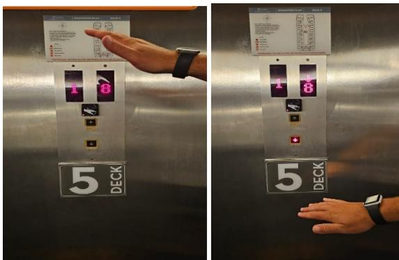
Рисунок 3. Интерактивная бесконтактная панель управления лифтом.
